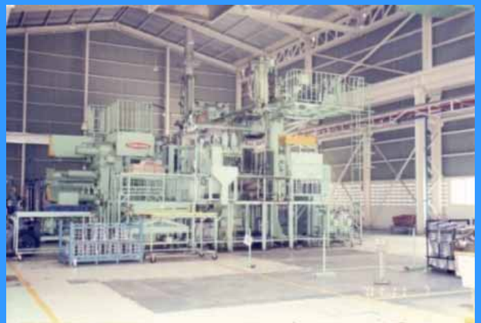
Installation for 1.600 Ton Die Casting Press Machine
